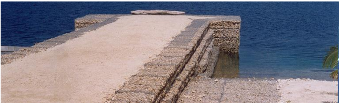
Figura 10. Rompeolas y estructura de protección costera
