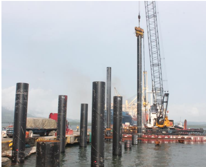
Figura 16. Pilotes de acero
