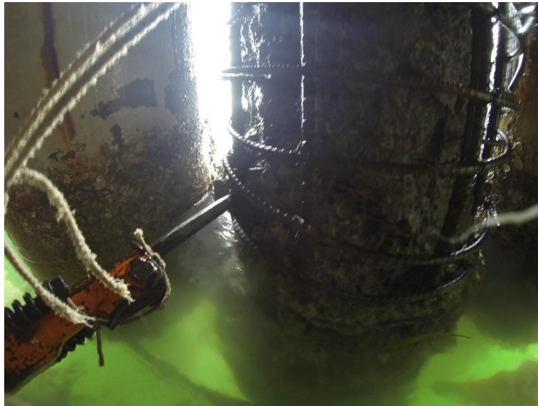
Figura 15. Demolición con herramientas neumáticas
