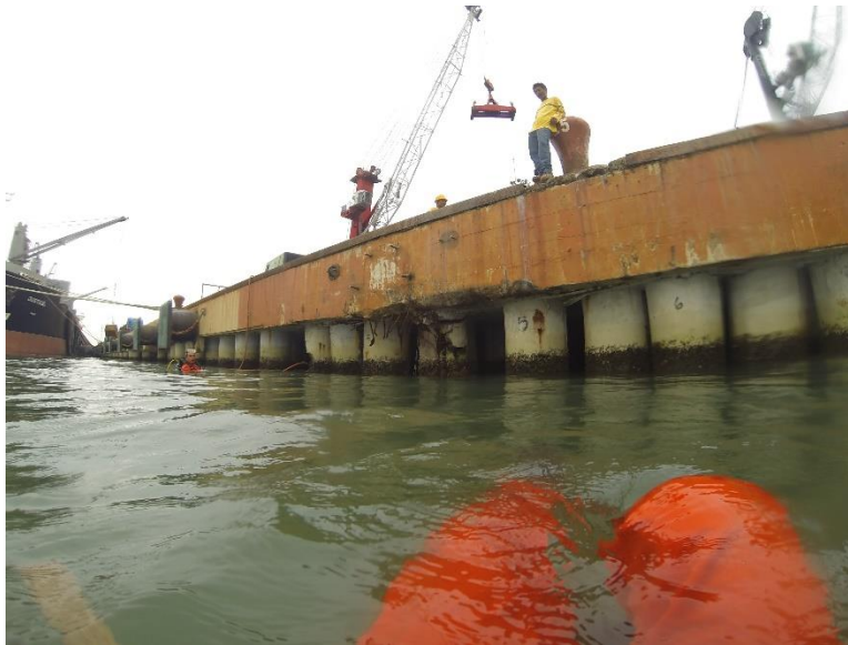
Figura 17. Encamisado en pilotes de concreto
