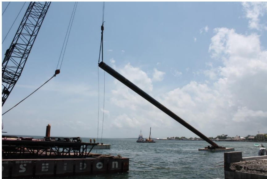
Figura. 20. Izaje de pilote
