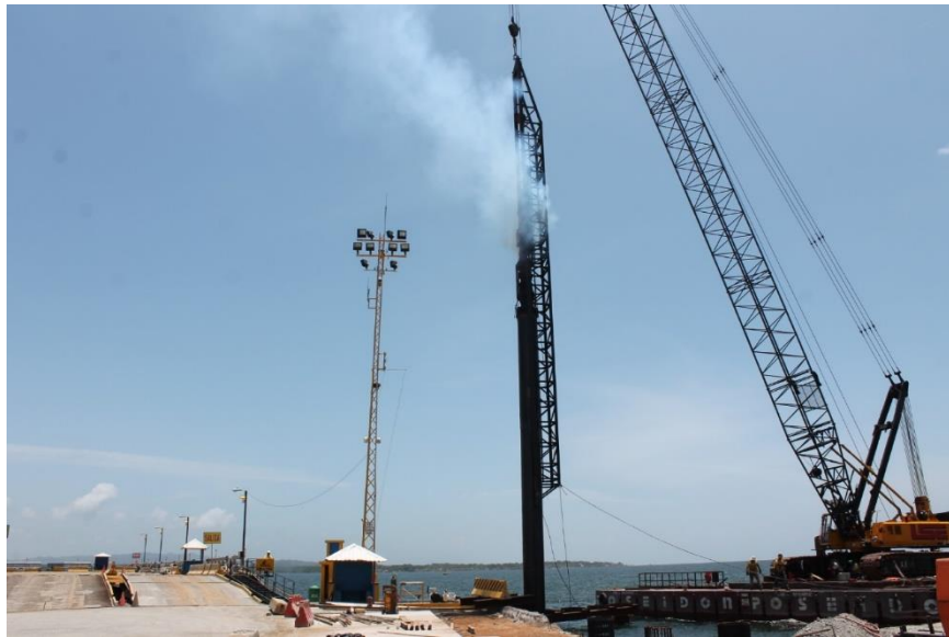
Figura 22. Hincado con martillo diésel
