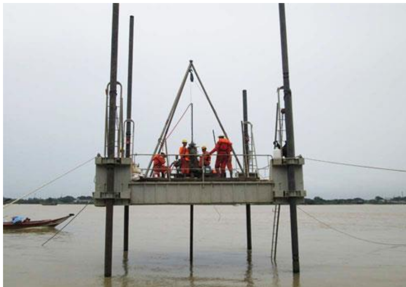
Figura 11. Ensayo SPT de lecho marino
