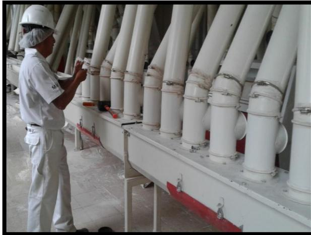
**Imagen No. 3.** Operario desmontando la tubería
