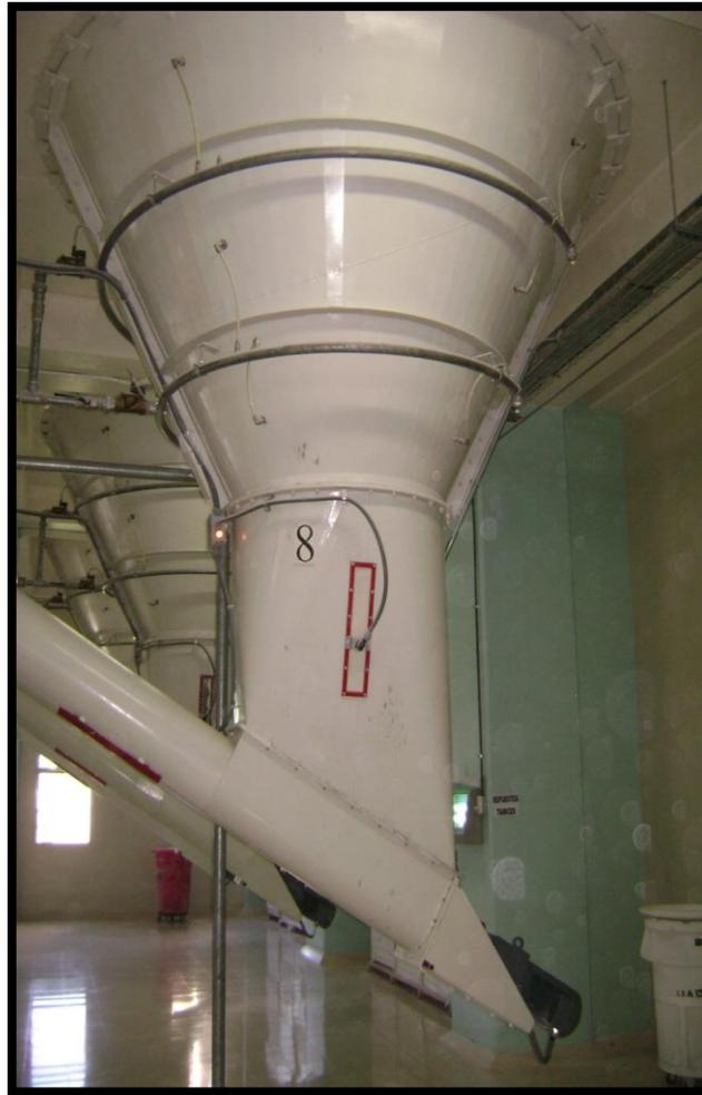
**Imagen No. 1.** Vista de las salidas de los silos
