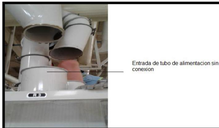
**Imagen No. 3.** Tubos de alimentación sin conexión
