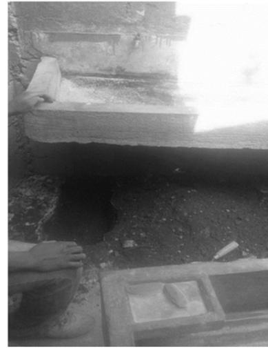
Se cavó una zanja de cada lado de la pileta para hacer la fundición de las columnas.
