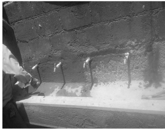
Se realizó el cambio por completo de toda la plomería de la pileta para evitar fugas de agua.
