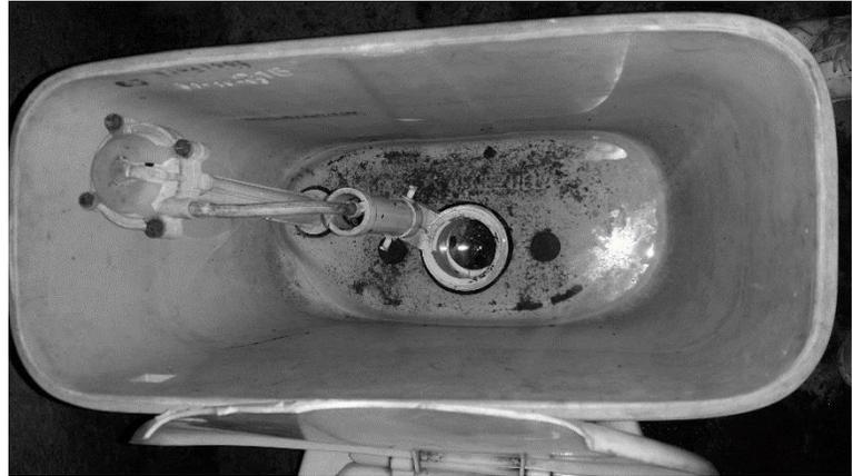
Figura 4. Tonel donde los niños recolectaban el agua para el sanitario, ya que este no contaba con el sistema de árbol de flote y sapo. Fuente: EPS 2017 – 2018, Aldea El Aguacate, Nentón, Huehuetenango.
