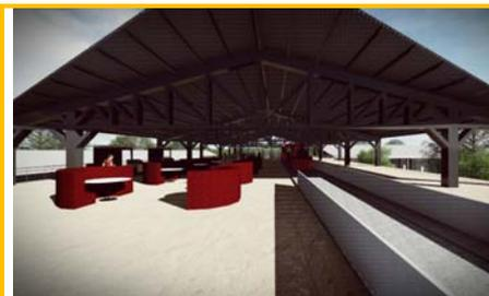
**Figura 97:** Aplicación del sistema constructivo de vigas tipo Howe + "joist", Elaborado por Kevin Bryan Argueta Sánchez, (Guatemala, 2016).
