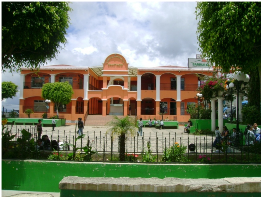
Figura 2. Centro Comercial y Parque Central
