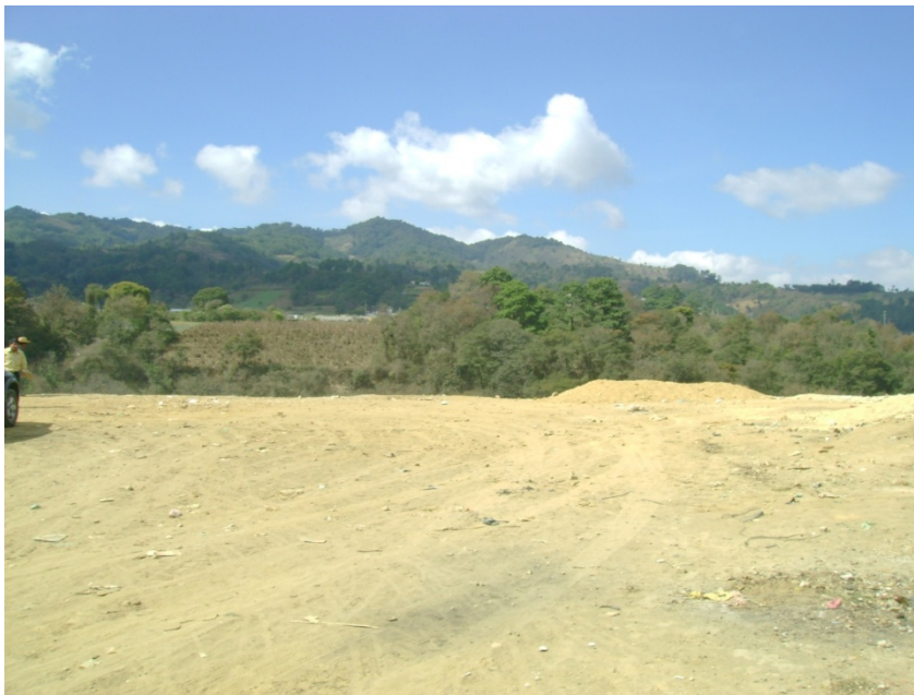
Figura 7. Botadero carretera a Santa María Cauqué, en proceso de cierre
