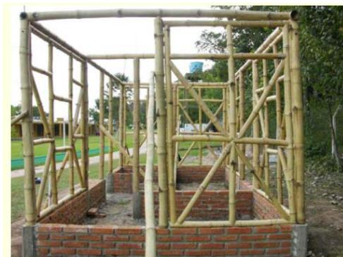
Se implementó un sistema de diafragmas que obligue al trabajo conjunto de los muros estructurales, mediante amarres que transmitan a cada muro la fuerza lateral que deba resistir.
