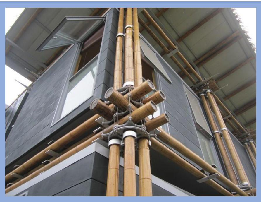
Imagen No.29-Fuente Plataforma Arquitectura, Detalle de unión entre columna y viga.
