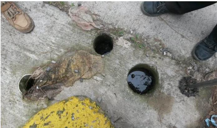
Figura 54A. Llaves de compuerta ubicadas cerca del tanque del cementerio
