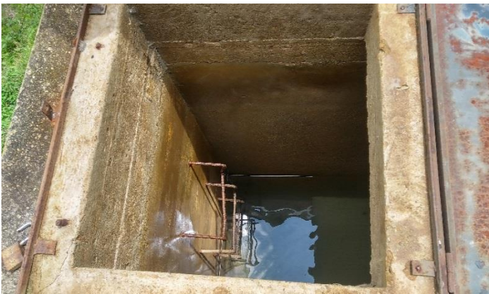
Figur6A. Entrada para realizar la limpieza del tanque de almacenamiento
