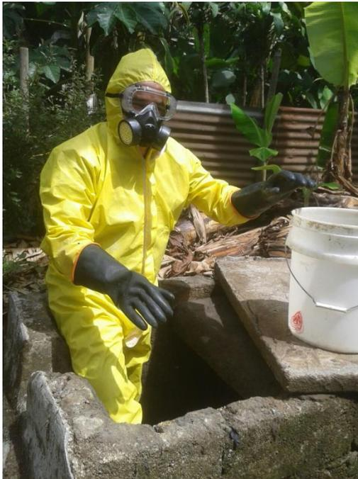
**Figura No.4:** Medición de caudal de fosa séptica El Socorro No. 1
