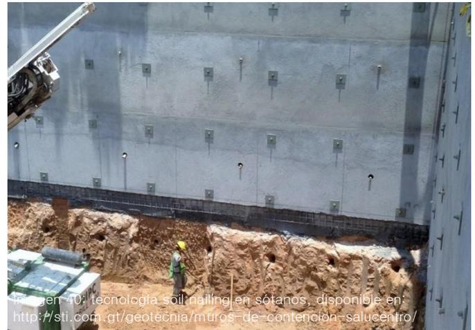
Imagen 40: tecnología soil nailing en sótanos, disponible en: <http://sti.com.gt/geotecnia/muros-de-contencion-salucentro/>
