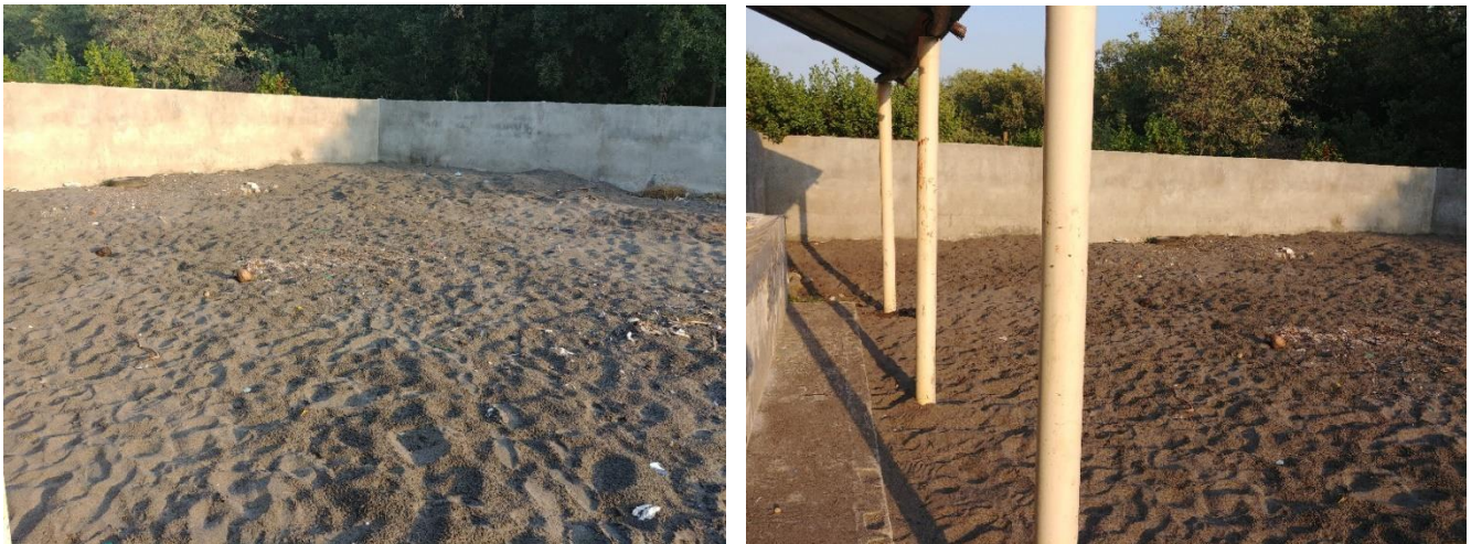
Fotografías de la parte trasera de la Escuela Oficial Rural Mixta (EORM) de Aldea Los Macizos Chiquimulilla, Santa Rosa, luego de eliminar el basurero y realizar el relleno sanitario.
