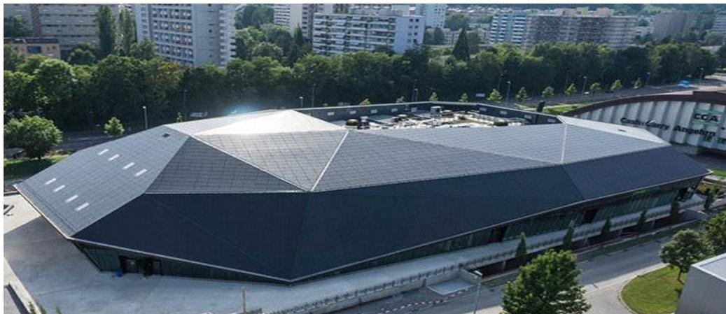
Fuente: *Panel solar fotovoltaico monocristalinas, integrados en edificios.* <http://www.archiexpo.es/prod/3s-swiss-solar-systems/panel-solar-fotovoltaico-bipv-integrado-edificio-62594172569.html>. Consulta: 7 de noviembre de 2014.
