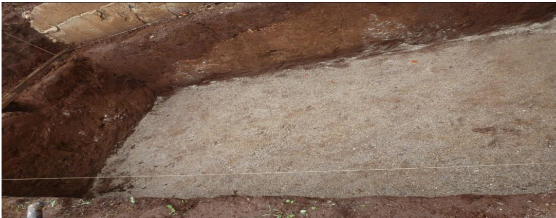
Fotografía 1. Nivelación del terreno
