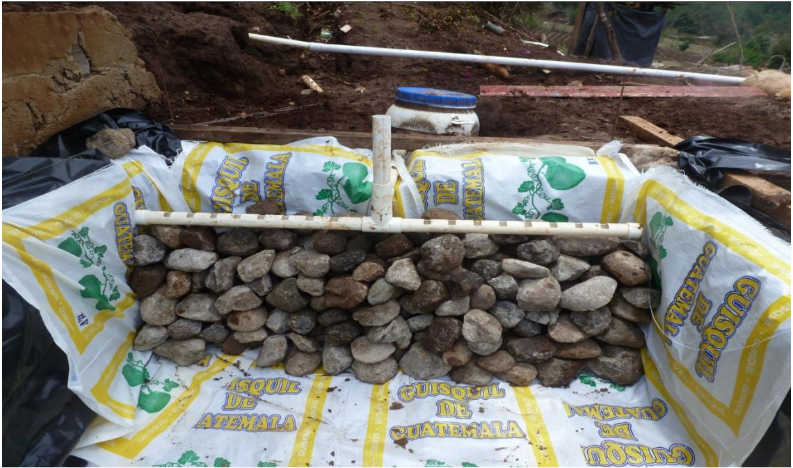
Fotografía 3. Colocación del material filtrante
