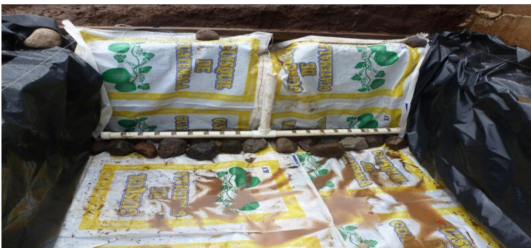
Fotografía 2. Impermeabilización de la biojardinera
