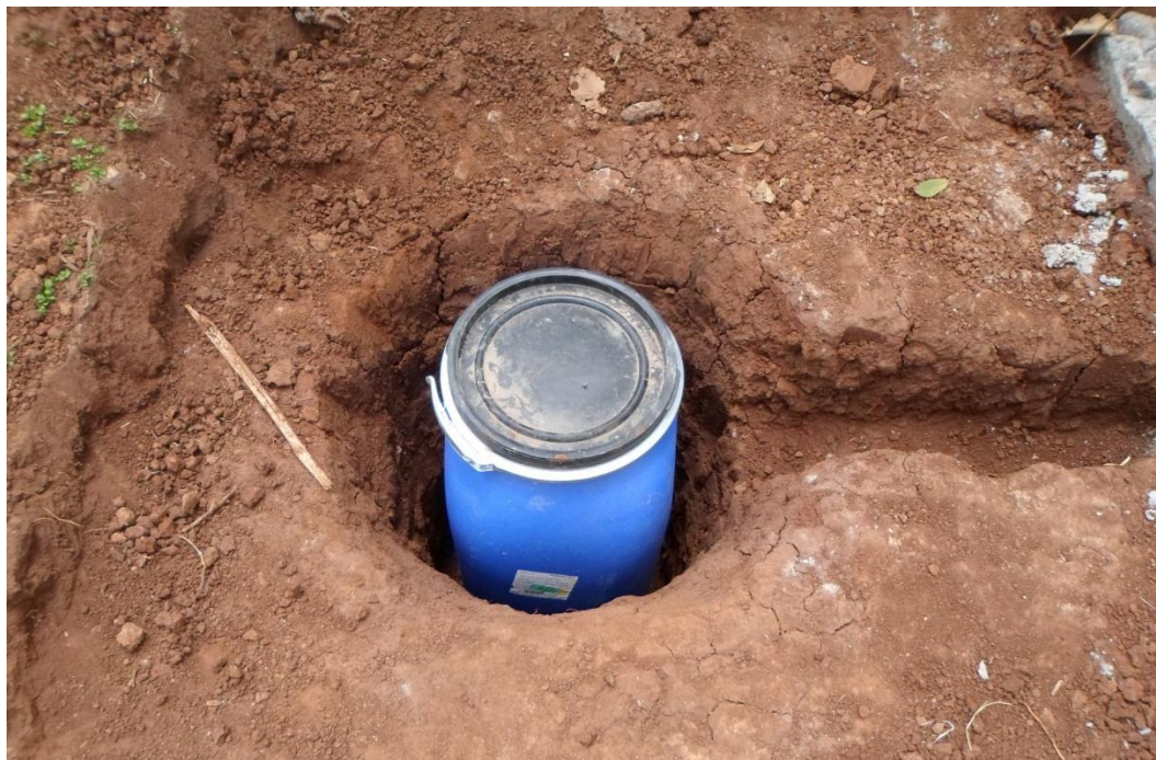
Figura 13. Detalle del tanque de almacenamiento para reutilización de agua tratada
