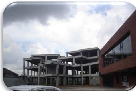
Fotografía 31 Construcción de nuevo edificio
