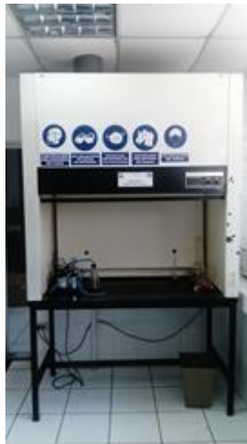
Figura 13. Campana de extracción
