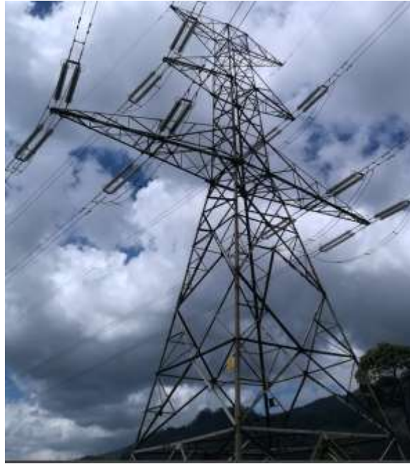
Figura 20. Fotografía de estructura de celosía
