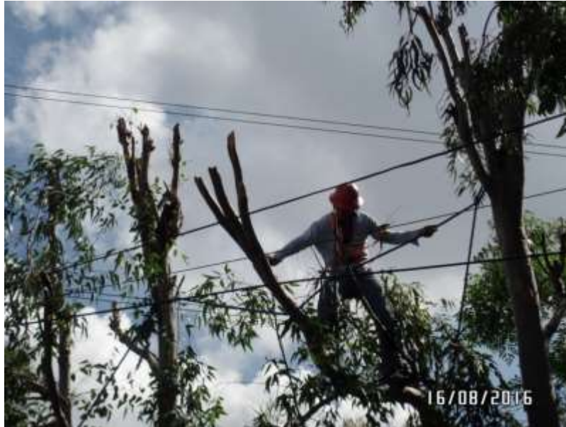
Figura 42. Liniero efectuando recorte de ramas
