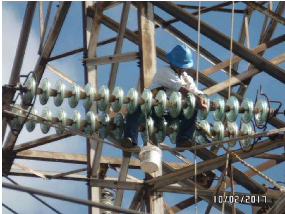
Figura 43. Liniero efectuando limpieza de aislamiento
