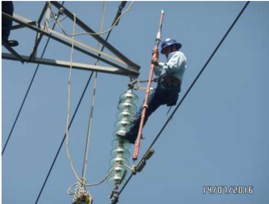
Figura 44. Liniero efectuando cambio de aislamiento
