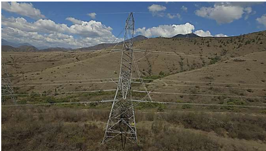
Figura 63. Vista de estructura de celosía
