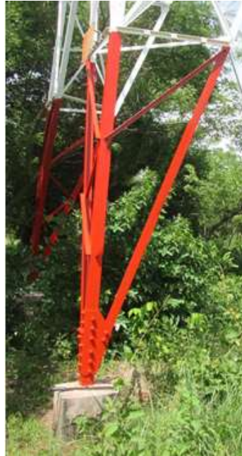
Figura 41. Ejemplo de angulares robados en una base
