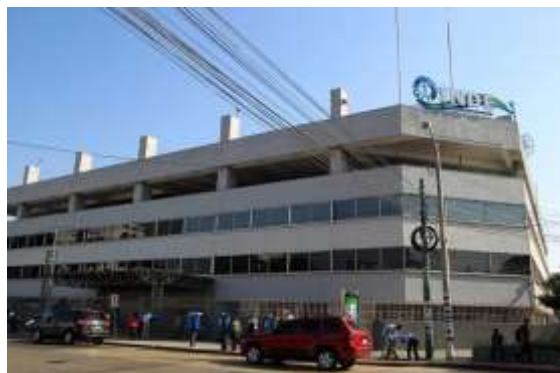
Figura 26. Vista local de sede de ETCEE – INDE
