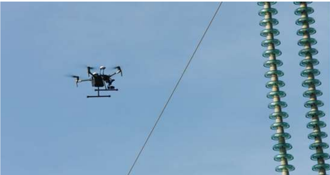
Figura 54. Dron Matrice 210 RTK inspeccionando aislamiento
