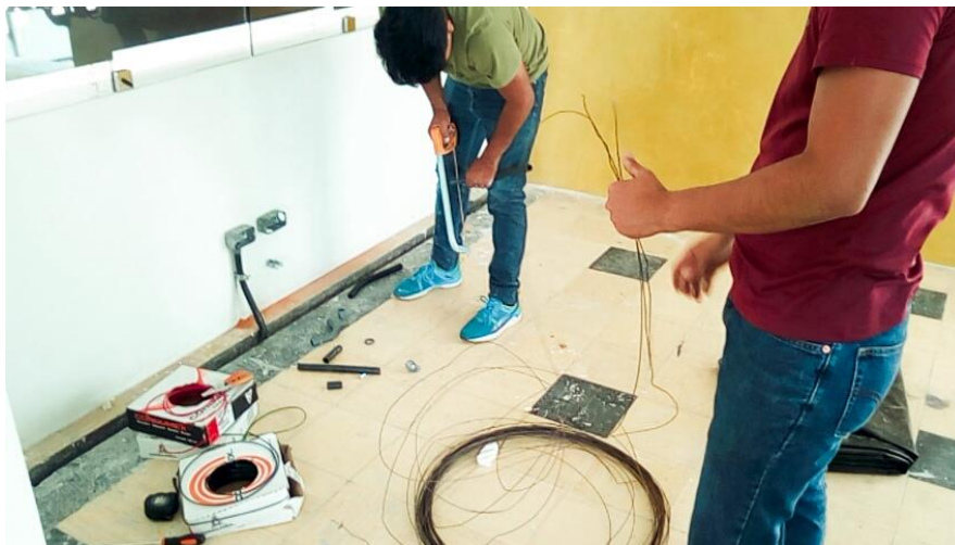
Figura 78. Instalación del cableado eléctrico en el Laboratorio India 3
