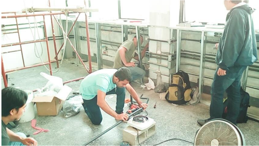
Figura 75. Instalación del cableado eléctrico en el Laboratorio India 3
