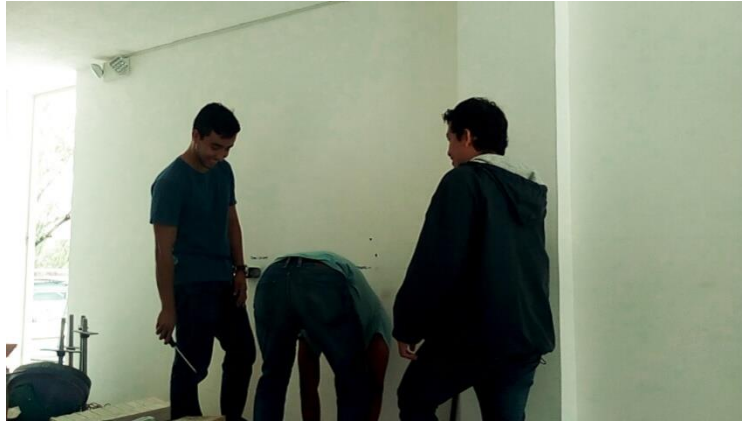
Figura 73. Instalación del cableado eléctrico en el Laboratorio India 3
