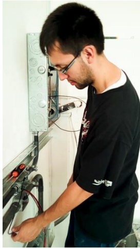
Figura 84. Conexión eléctrica hacia el tablero de flipones en el Laboratorio India 3
