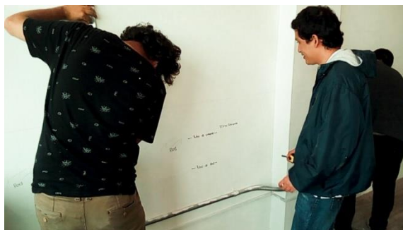
Figura 62. Medición de las distancias entre puntos de red y tomacorrientes en el Laboratorio India 3
