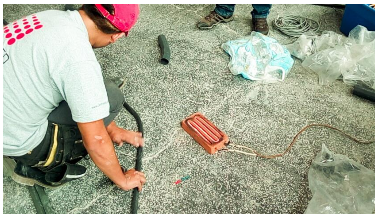
Figura 74. Instalación del cableado eléctrico en el Laboratorio India 3
