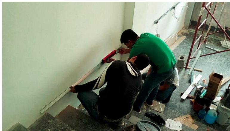
Figura 72. Instalación del cableado eléctrico en el Laboratorio India 3
