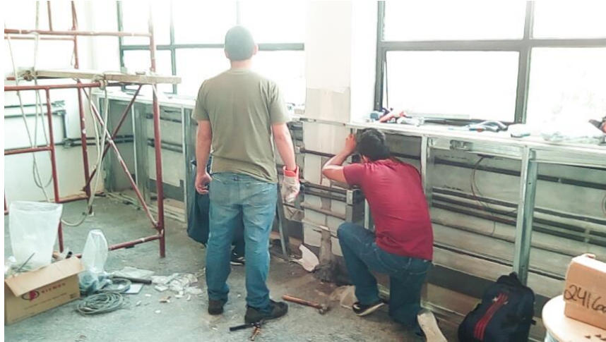
Figura 77. Instalación del cableado eléctrico en el Laboratorio India 3
