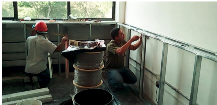
Figura 67. Instalación de las tuberías de los tomacorrientes en el Laboratorio India 3
