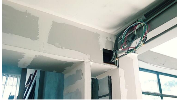
Figura 56. Entrada Laboratorio India 3 previa a la remodelación
