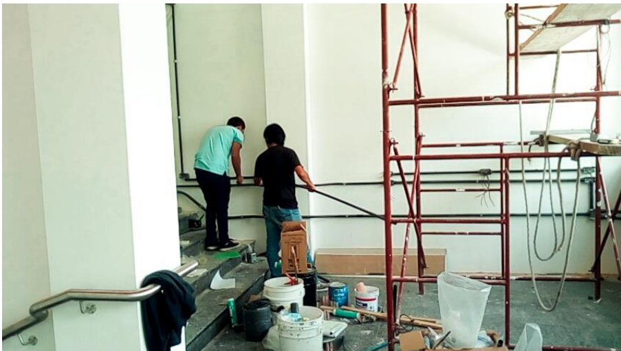
Figura 76. Instalación del cableado eléctrico en el Laboratorio India 3
