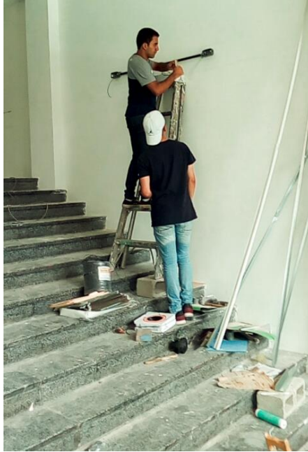
Figura 71. Instalación del cableado eléctrico en el Laboratorio India 3
