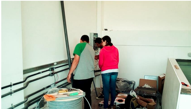
Figura 81. Instalación del cableado eléctrico en el Laboratorio India 3
