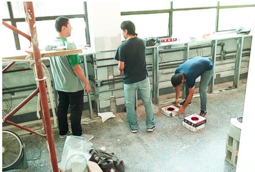
Figura 80. Instalación del cableado eléctrico en el Laboratorio India 3
