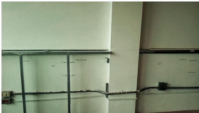
Figura 66. Marcado de las tuberías para los puntos de red y los tomacorrientes en el Laboratorio India 3
