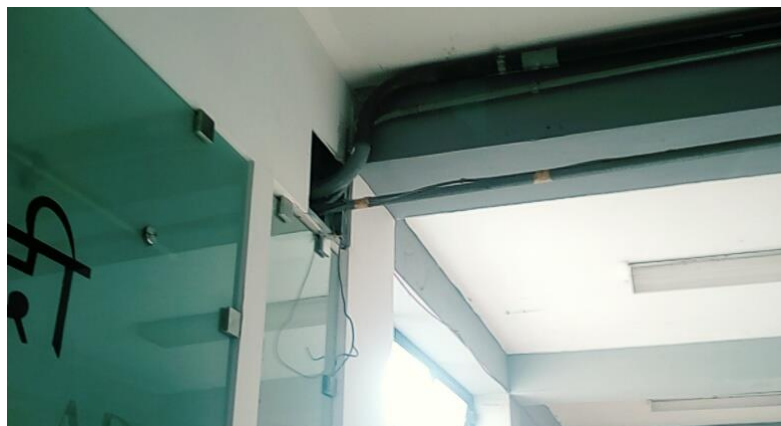
Figura 60. Entrada Laboratorio India 3 después de la remodelación
