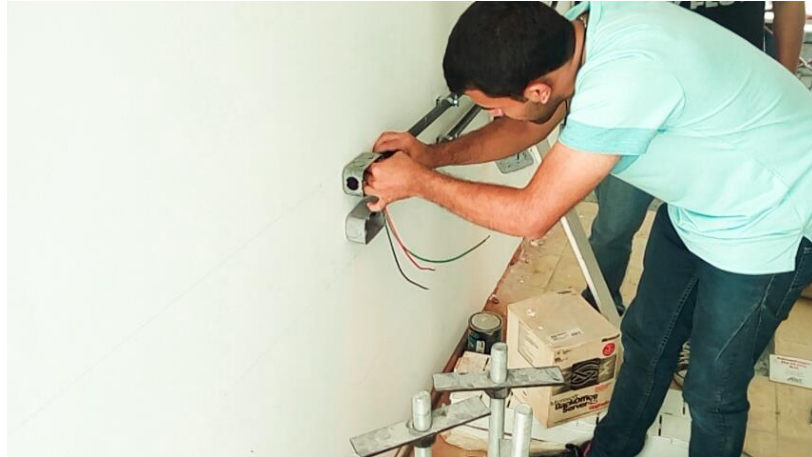
Figura 79. Instalación del cableado eléctrico en el Laboratorio India 3
