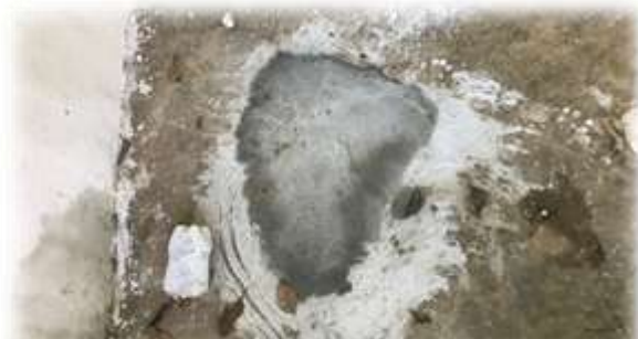
Figura 16. Mejoramiento de casco de la finca. Fuente: Autor 2017
