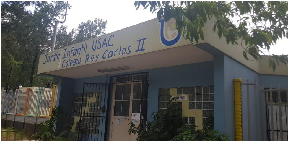
Figura 5. Iluminación de exterior de ingreso del Jardín Infantil
