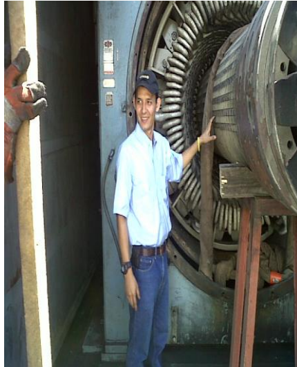
Figura 24. Desmontaje del rotor de la unidad generadora gas núm. 3
