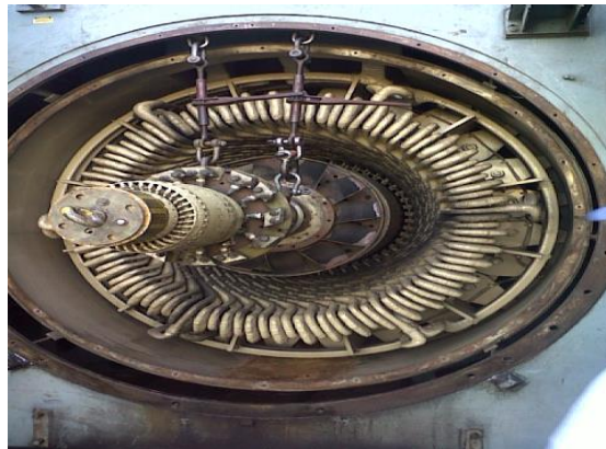
Figura 26. Desmontaje del rotor de la unidad generadora gas núm. 4
