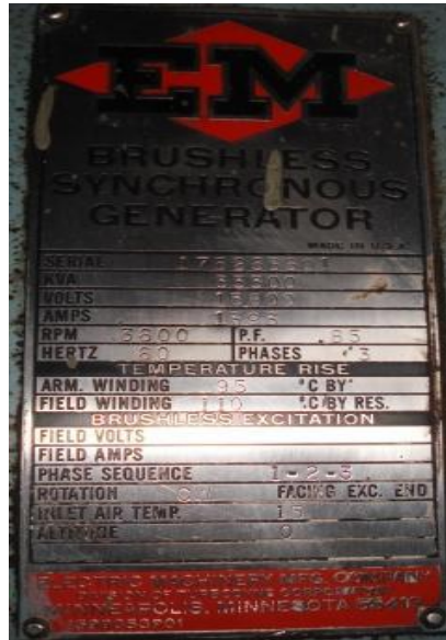
Figura 22. Placa de datos de la unidad generadora gas núm. 3
