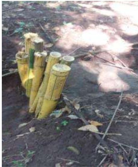
Figura 31. Erosión de suelo controlada por colocación de barrera.
