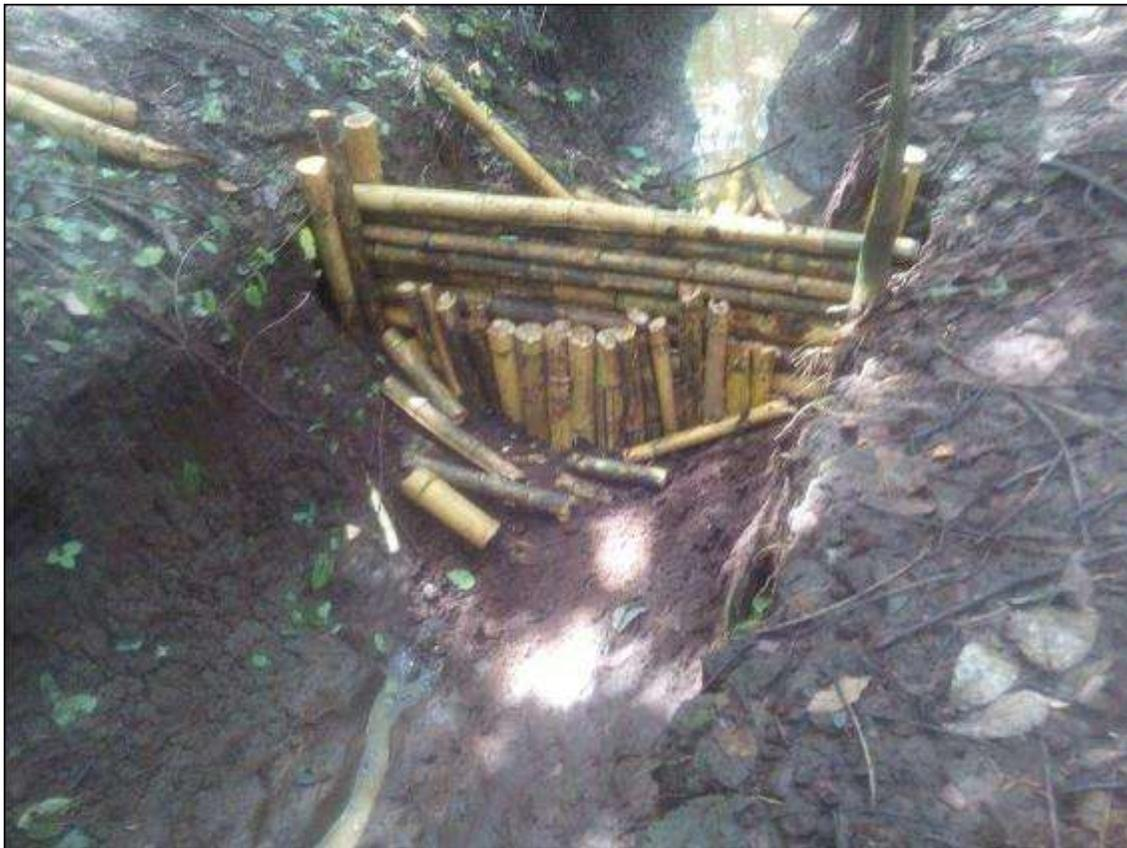
Figura 28. Barrera combinada para mejor la resistencia a la corriente de agua.
