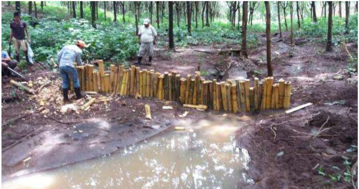
Figura 26. Colocación de barrera a lo ancho de la cárcava formada por erosión hídrica.
