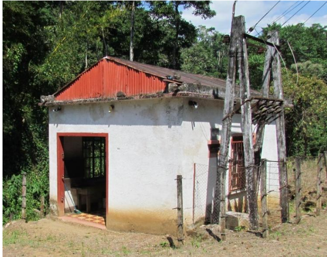
Figura 44. Exterior de la casa de máquinas
