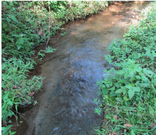
Figura 40. Parte del canal sin revestimiento
