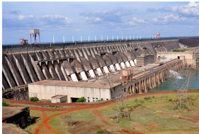
Figura 3. Represa de la central hidroeléctrica Itaipú
