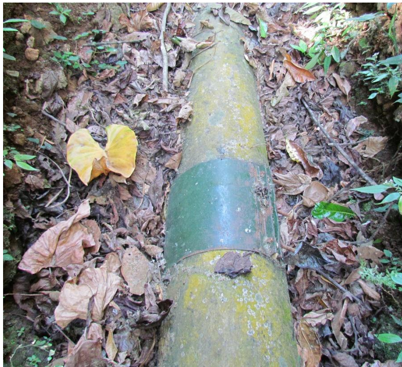
Figura 43. Parte reparada de la tubería de presión
