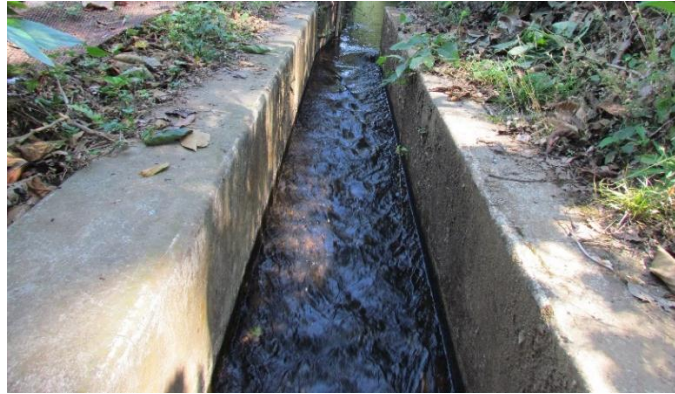
Figura 39. Parte del canal con revestimiento de cemento
