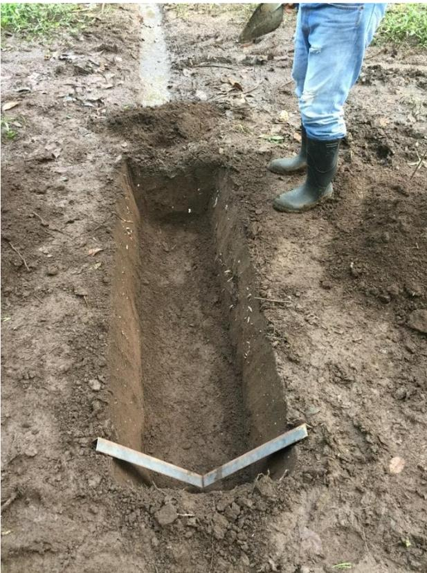
Figura 10: Construcción del vertedero triangular
