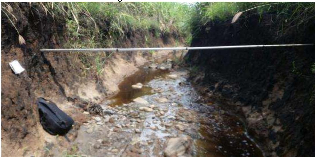
Imagen 3. Canal de riego con un grado de erosión demasiado alto.
