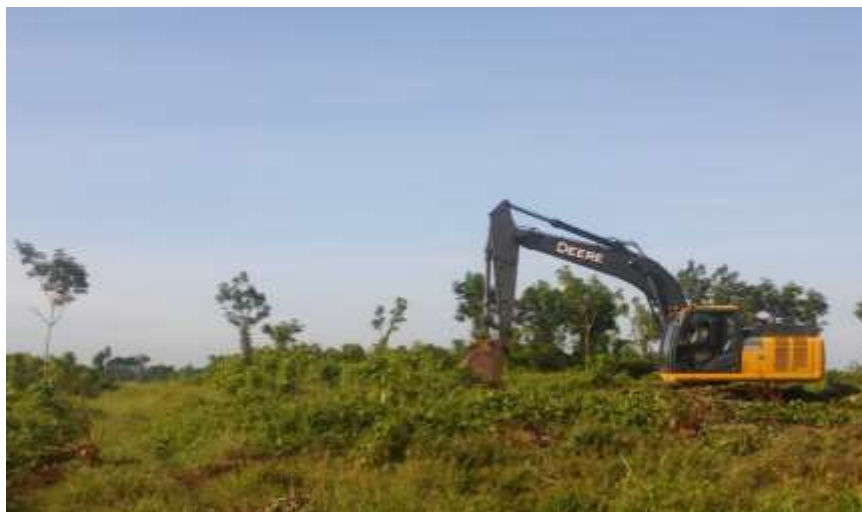
Figura No.13: Máquina Excavadora Jonh Deere 210 G en labor de descombro de árboles de hule en plantilla
