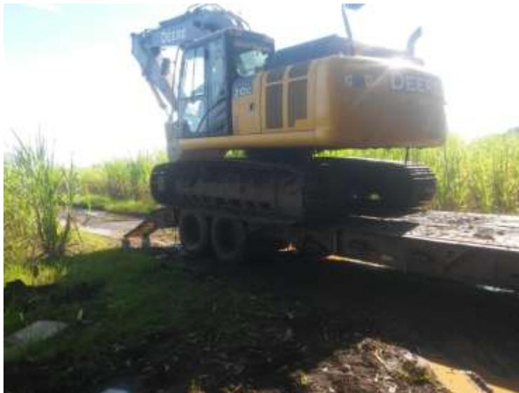
Figura No.10: Excavadora utilizada para el descombro de arboles
