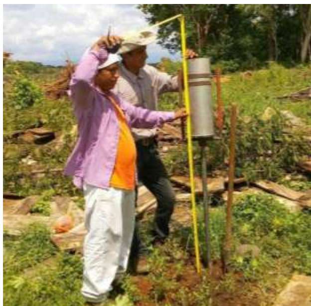
Figura No 16. Medición de la altura de pluviómetro al momento de su instalación
