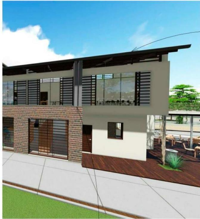
LA DOBLE COLUMNA PERMITE OCULTAR EN EL CENTRO EL TUBO DE PCV, QUE RECOLECTA LAS AGUAS DE LLUVIA
