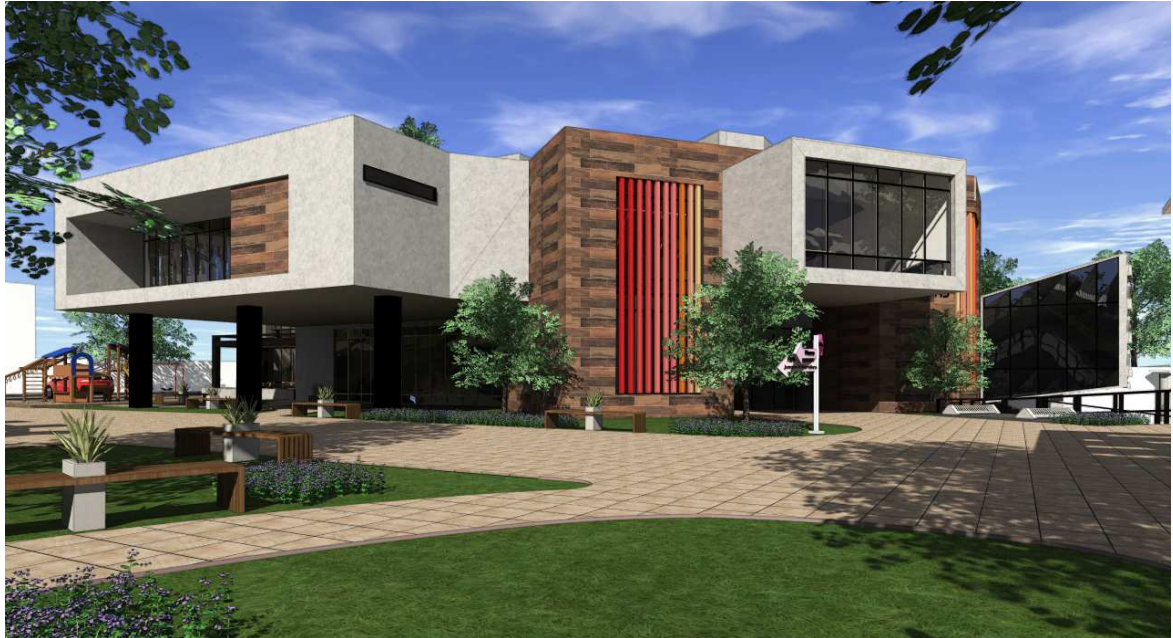
VISTA OESTE BIBLIOTECA MUNICIPAL.
