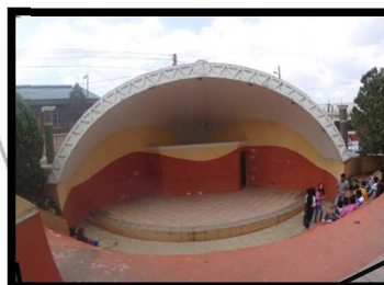
Fotografía No. 20 concha acústica
