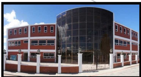
Fotografía No. 26 Palacio municipal
