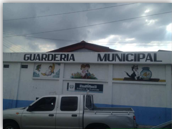
Fotografía No. 38 Guardería municipal (colindancia)
