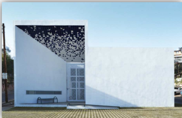
Fotografía No. 65 Ingreso principal.
