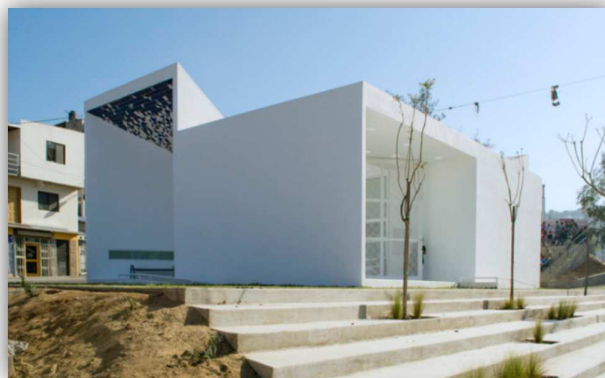
Fotografía No. 66 Perspectiva lateral.
