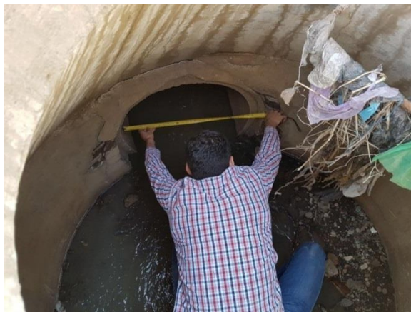
Figura 13. Levantamiento de información de redes de alcantarillado
