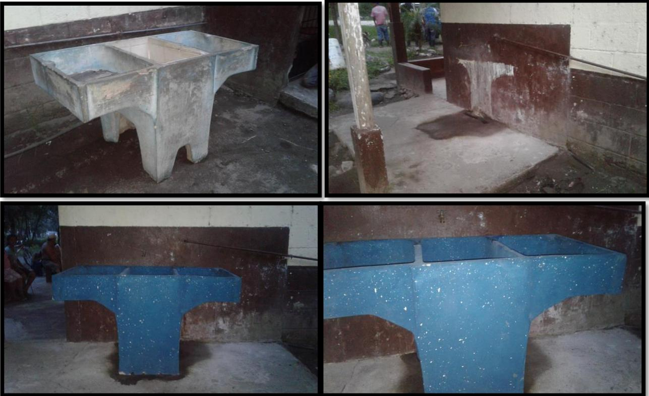
Fuente: Ana Cecilia Consuegra. En la fotografía se observa el mal estado de la pila, luego el espacio que quedó al remover la pila en mal estado y por último se observa la colocación de la pila nueva.
