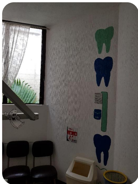
Colocación de reloj de pared
