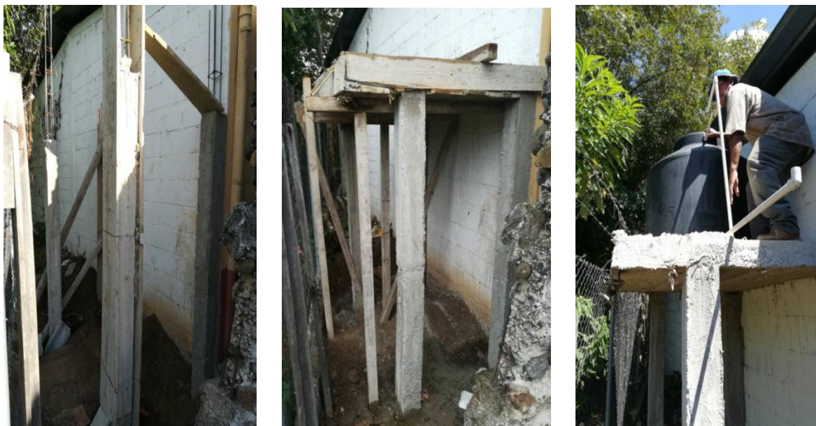
Figura No. 3. Construcción de las columnas y terraza para la instalación del depósito
