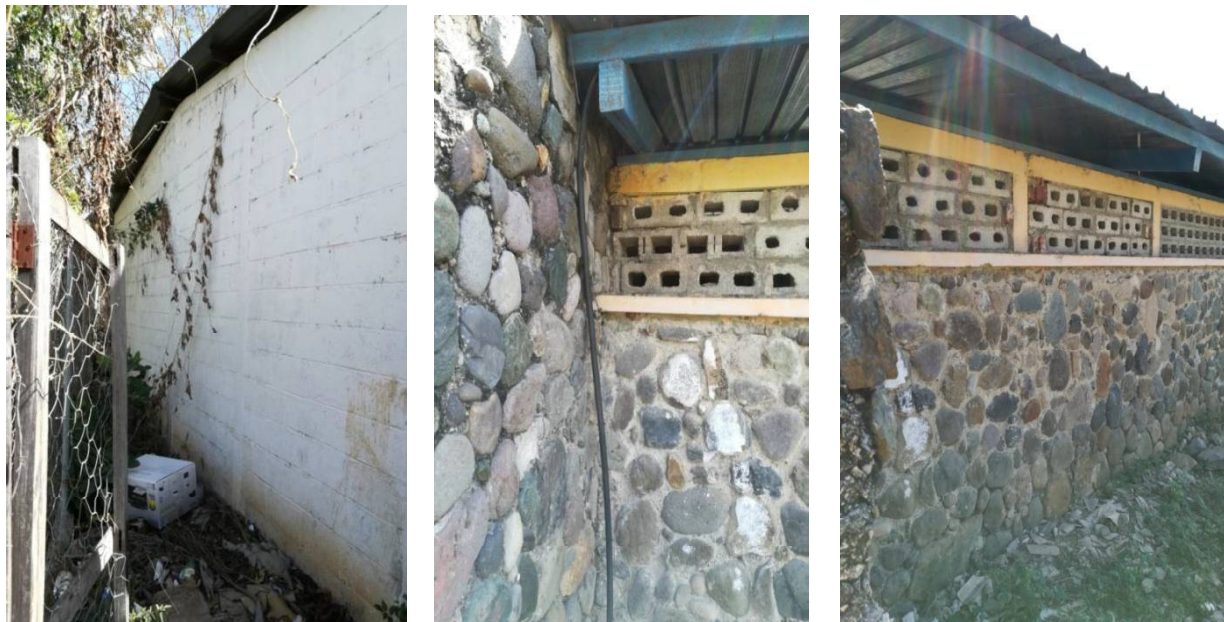
Figura No. 1. Área para la instalación y abastecimiento de agua para los sanitarios
