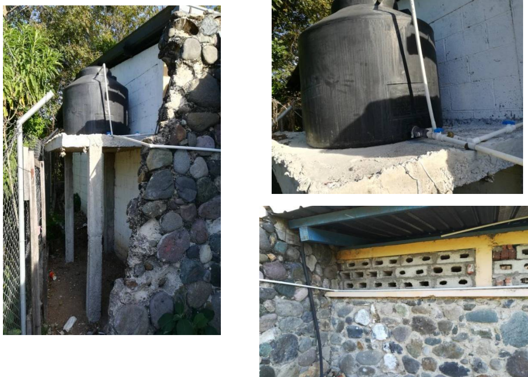
Figura No. 4. Proyecto finalizado
