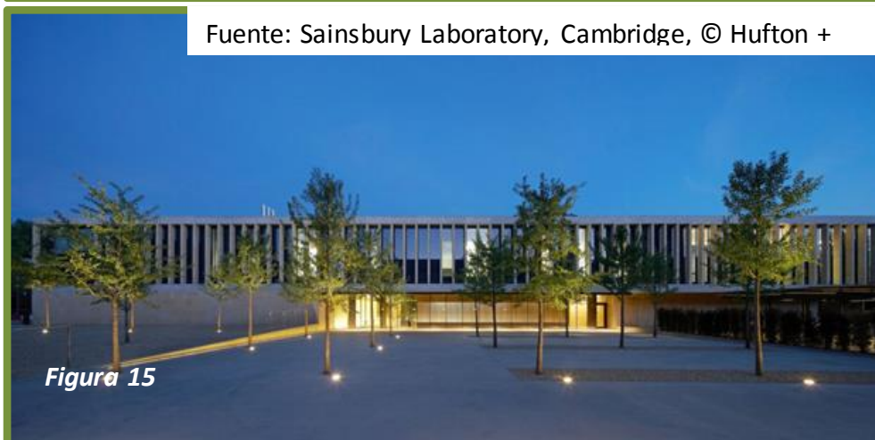
Figura 14 y 15. Vistas exteriores del Centro de investigación Sainsbury
