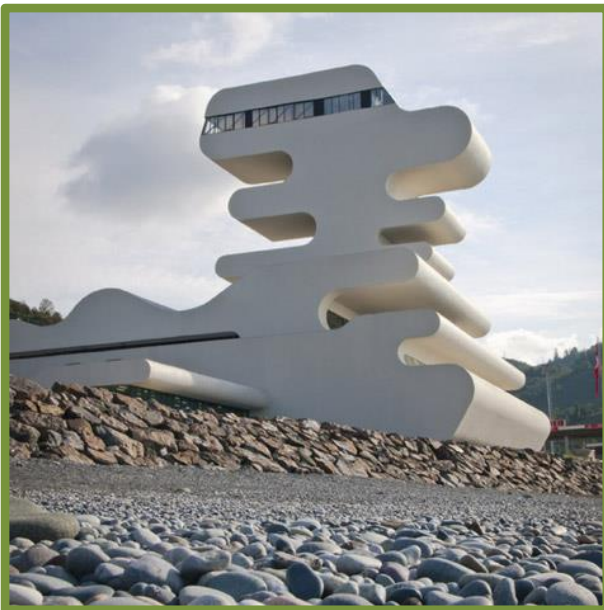
Figura 54. Torre de control de Puesto fronterizo Sarpi en Turquía.
