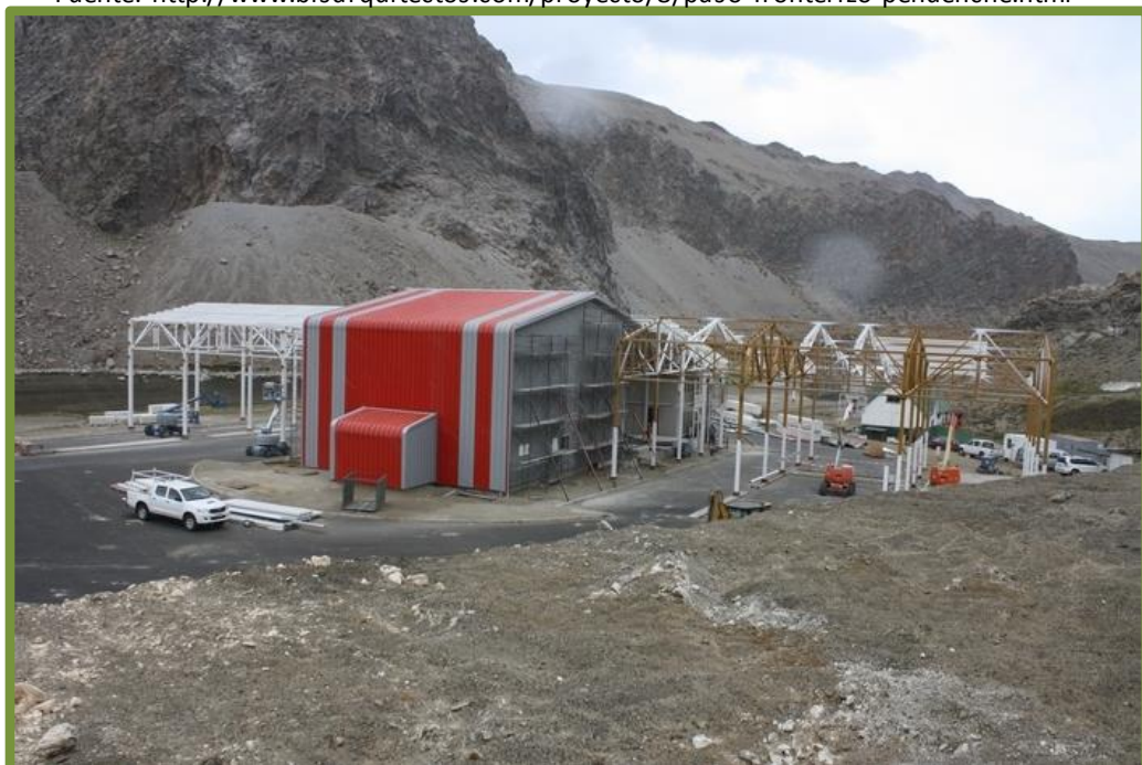
Figura 60. Ejecución de proyecto Paso Fronterizo Pehuenche.
