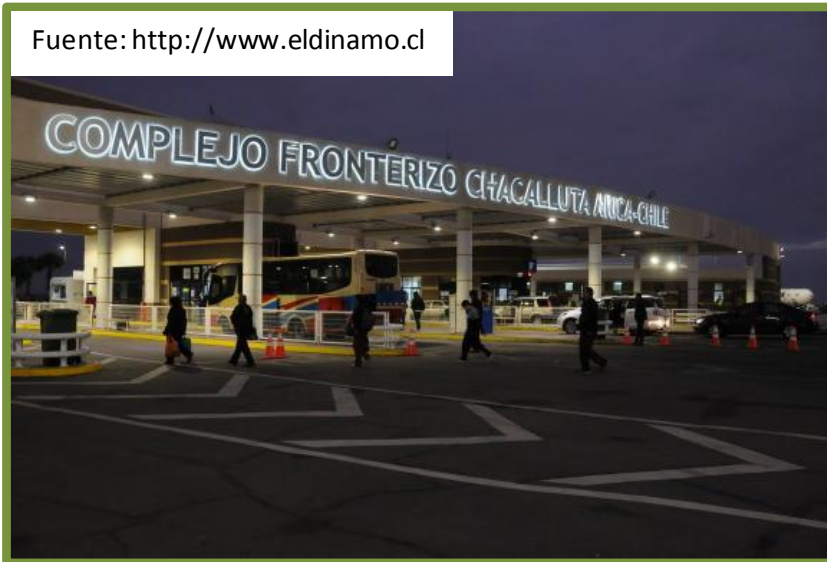
Figura 29. Complejo Fronterizo Chacalluta Chile
