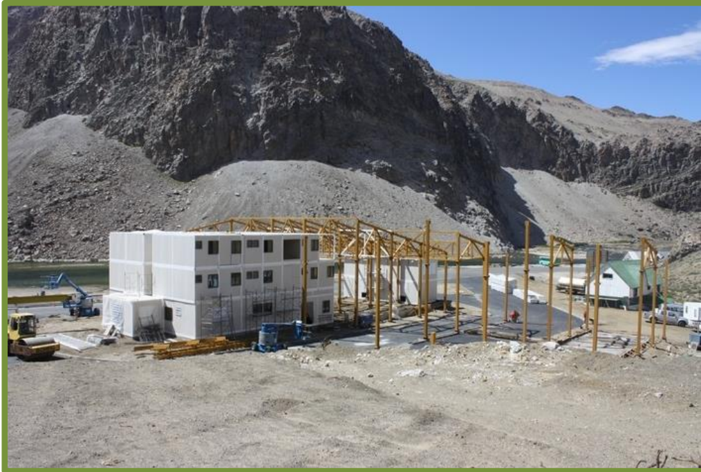
Figura 59. Ejecución de proyecto Paso Fronterizo Pehuenche.
