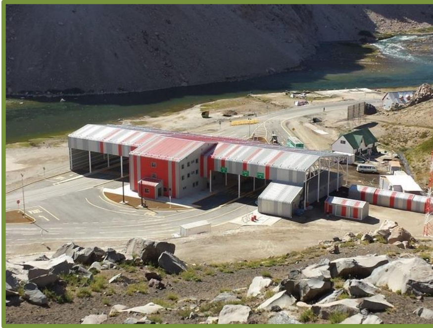
Figura 61. Ejecución de proyecto Paso Fronterizo Pehuenche.
