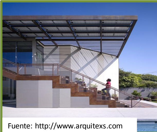
Figura 16. Vista exterior de casa sostenible Yin-Yang
