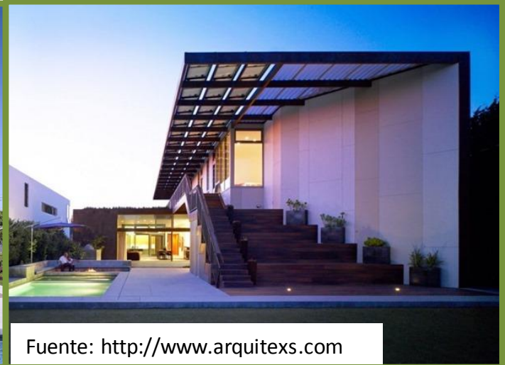
Figura 17. Vista exterior de casa sostenible Yin-Yang
