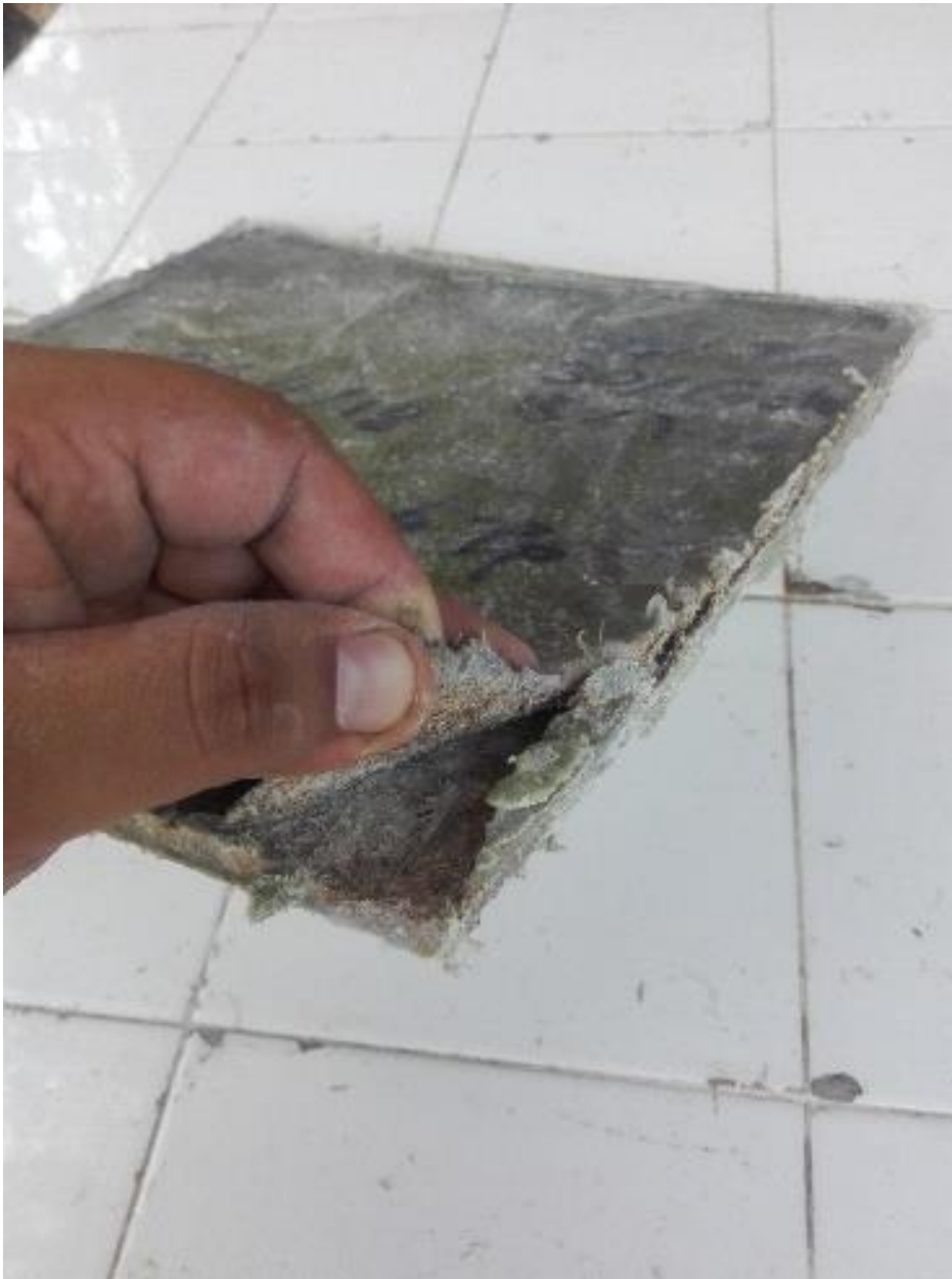
Figura 70. Polipropileno insuficiente
