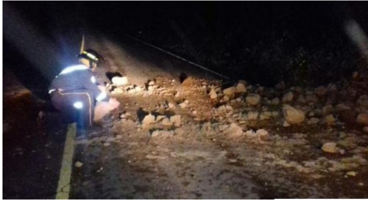
Figura 54. Deslave en el Km. 212. Ruta Quetzaltenango-Retalhuleu
