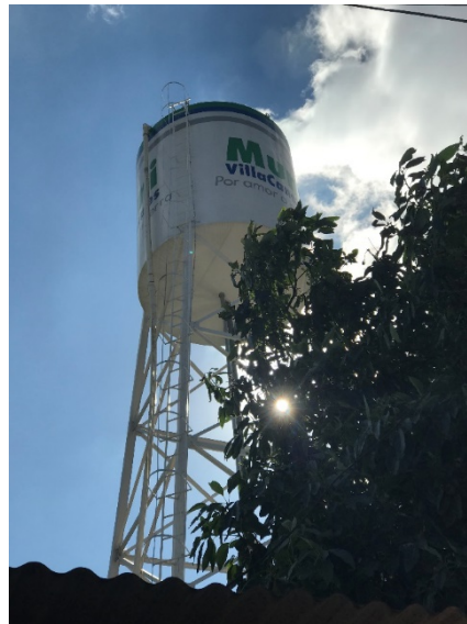
Figura 25. Tanque de almacenamiento El Zapote
