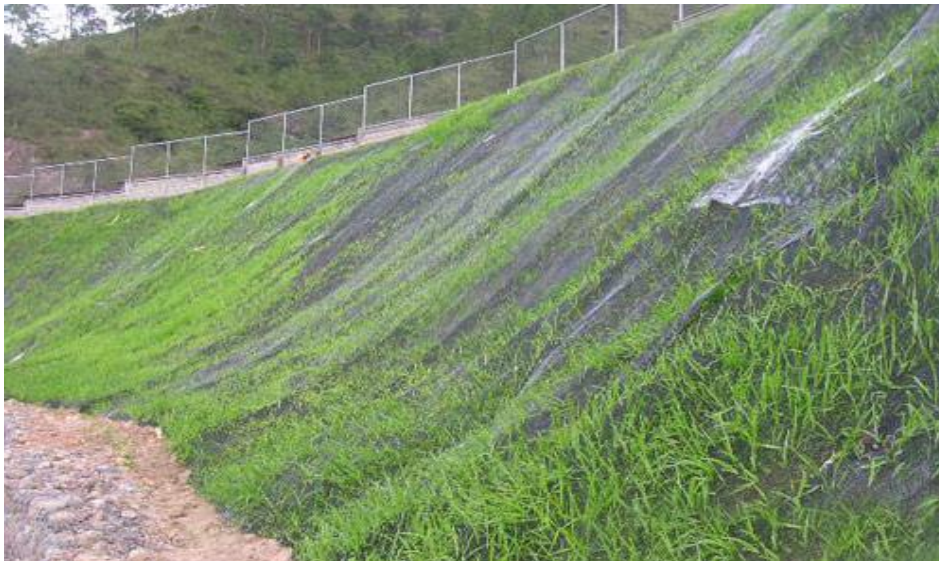
Figura 91. Protección control de erosión
