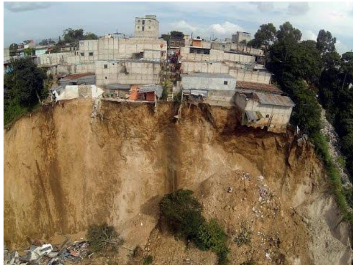
Figura 13. Deslizamiento en Loma Linda, Tierra Nueva I, Chinautla
