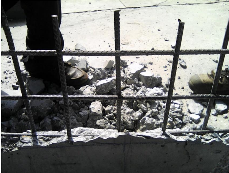
Figura 136. Refuerzo de electromalla en las placas. Posterior al trabajo por flexión
