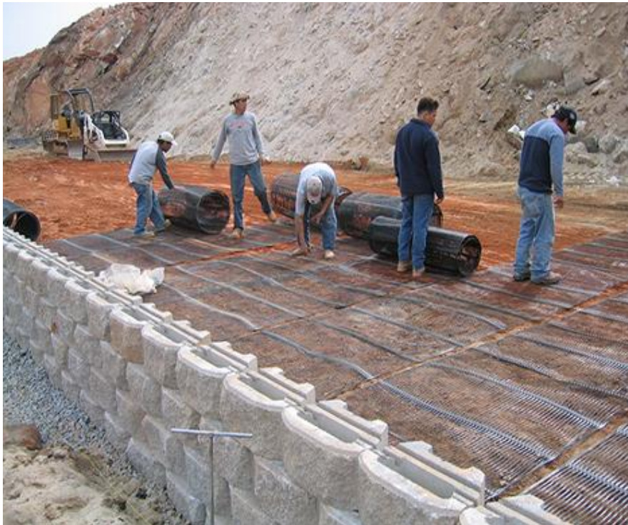
Figura 93. Colocación de geomalla uniaxial
