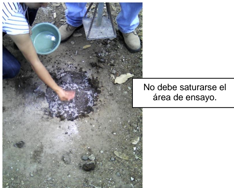
Figura 72. Humedecer cada capa de material para estabilización
