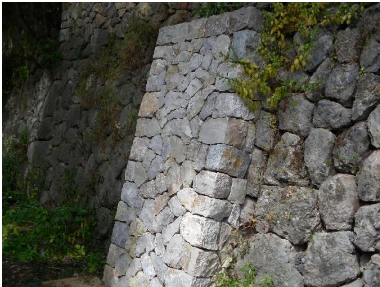
Figura 77. Muro de mampostería en seco
