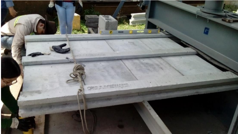
Figura 110. Preparación y nivelación del sistema placa-poste
