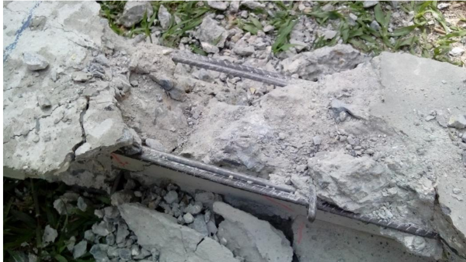
Figura 146. Análisis del refuerzo longitudinal del poste, posterior al ensayo del elemento
