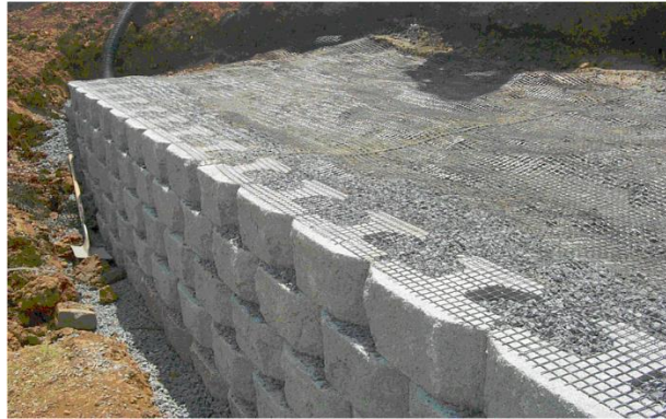
Figura 82. Muro de tierra reforzada (geomalla y bloques prefabricados de concreto)
