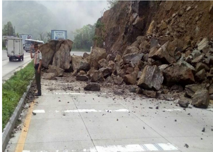
Figura 12. Caída de roca en vía ruta al Atlántico (Rodamiento)
