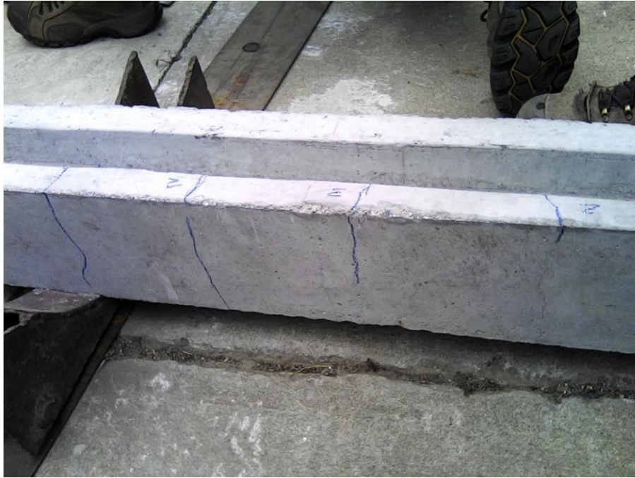
Figura 144. Fisuras visibles en la zona de tensión del elemento a flexión
