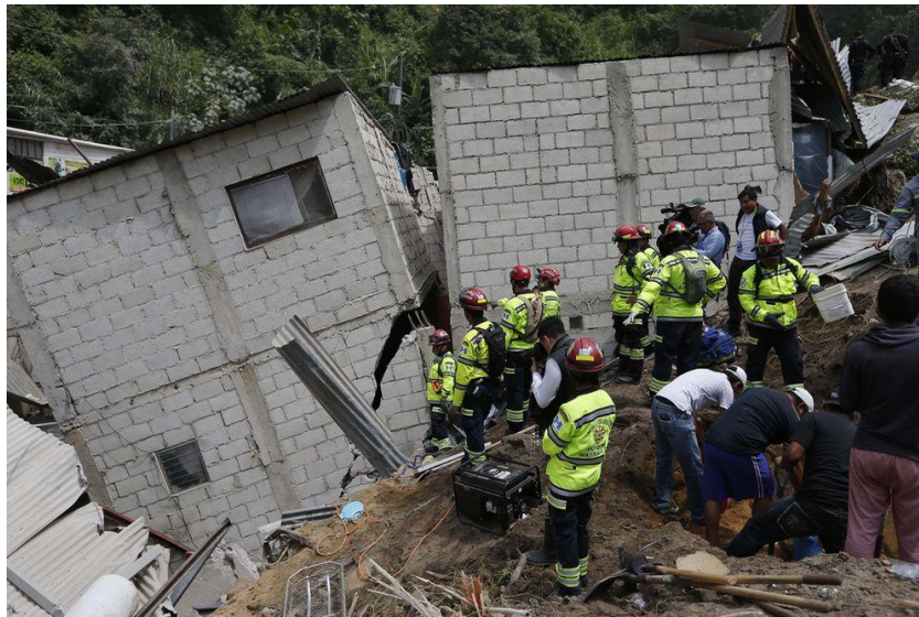
Figura 14. Derrumbe en zona 10 de la capital de Guatemala
