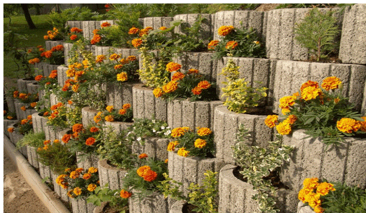
Figura 83. Muro de contención jardinera
