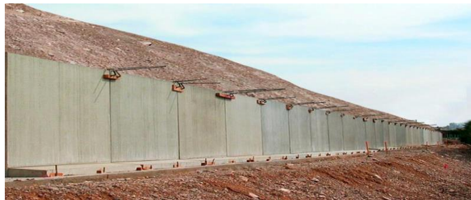
Figura 76. Muro de contención de concreto
