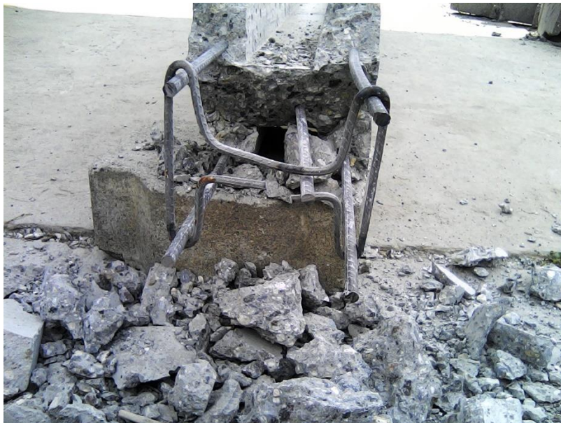
Figura 128. Análisis del refuerzo transversal del poste, posterior al ensayo del sistema
