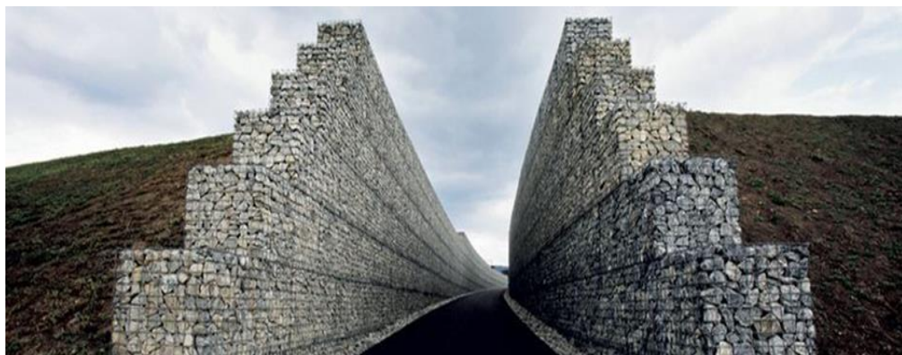
Figura 79. Muro de contención, elaborado con un sistema de gaviones
