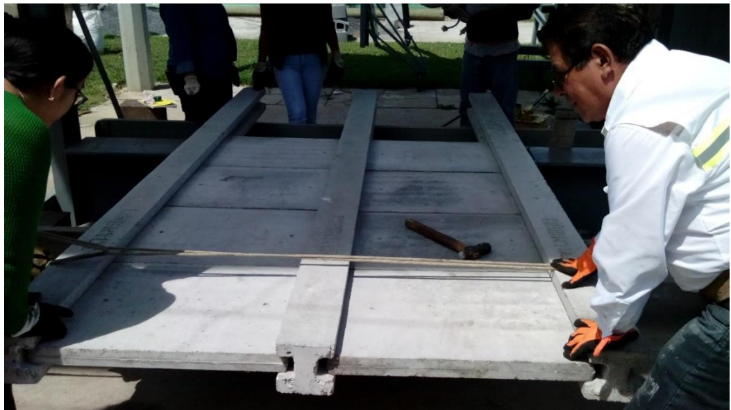
Figura 8. Colocación de placas, deslizándolas entre los postes
