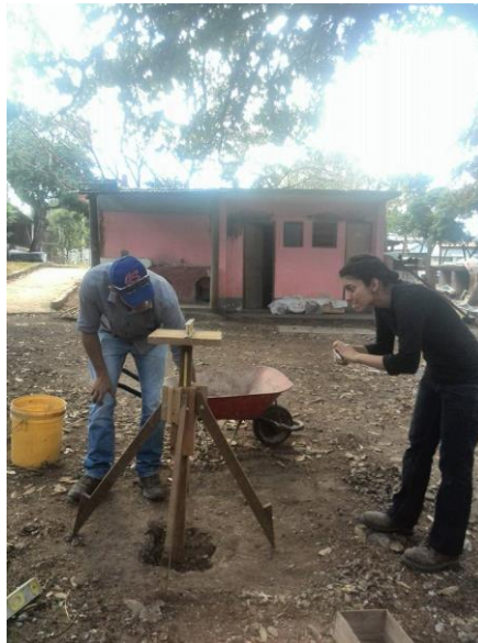
Figura 64. Colocación y nivelación del equipo
