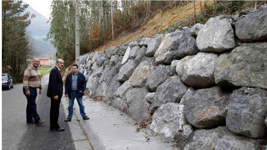
Figura 78. Muro de escollera de 30 m de largo y 2,5 a 4,5 m de altura
