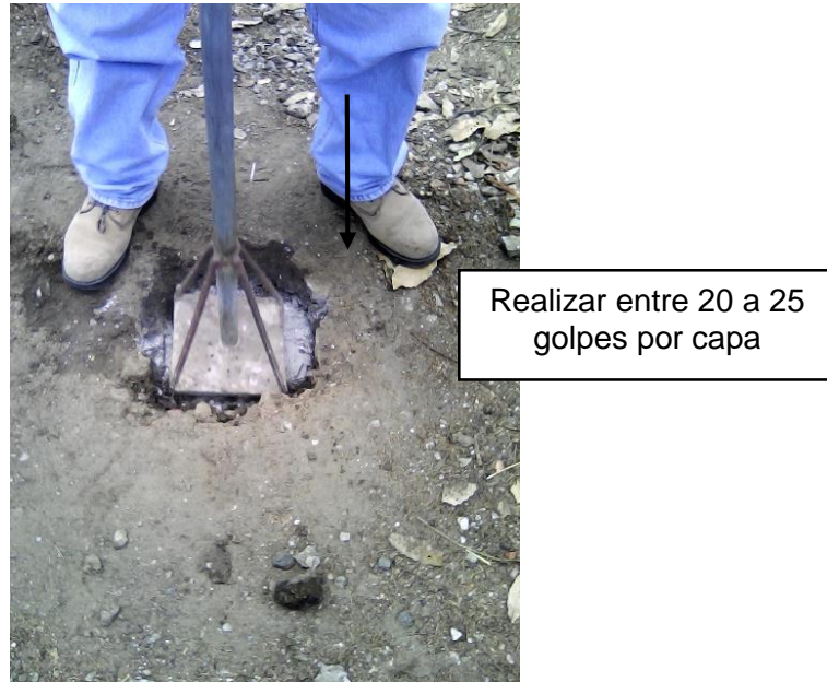
Figura 71. Apisonamiento de cada capa del nuevo material
