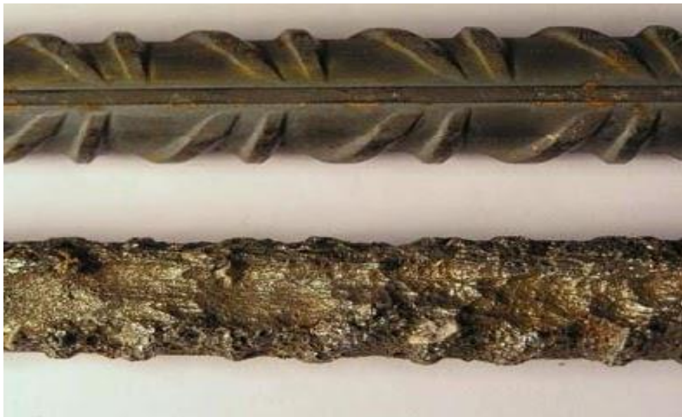
Figura 40. Corrosión por ion cloruro
