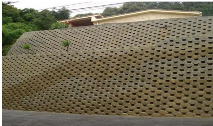
Figura 81. Criba (travesaños de concreto entrelazados formando un cajón)
