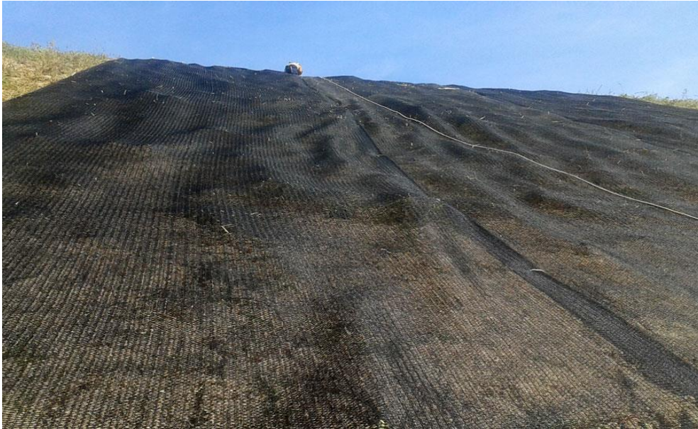
Figura 90. Sujeción de taludes
