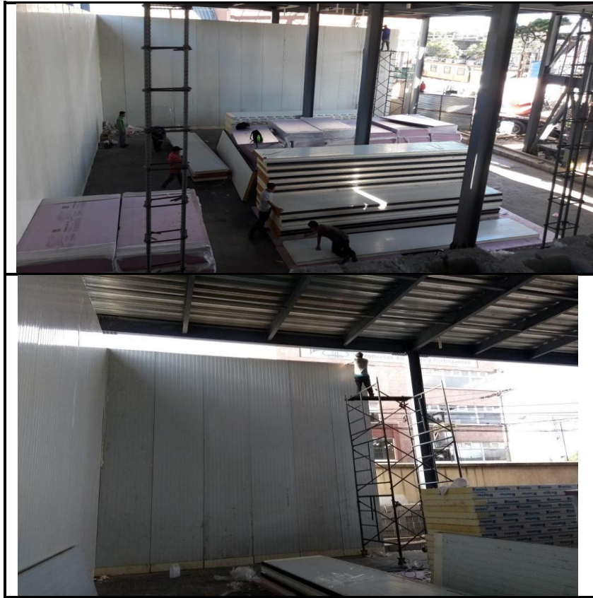
Figura 23. Vista de construcción de muros de cuarto frío
