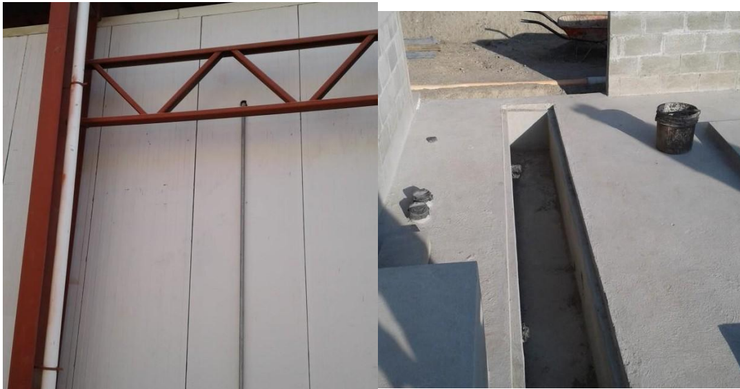
Figura 34. Detalles de drenajes de cuarto frío
