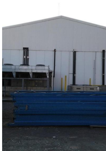
Figura 3. Vista de cuarto frío
