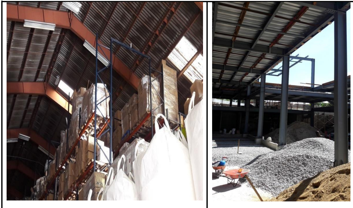
Figura 25. Vista de techo de cuarto frío
