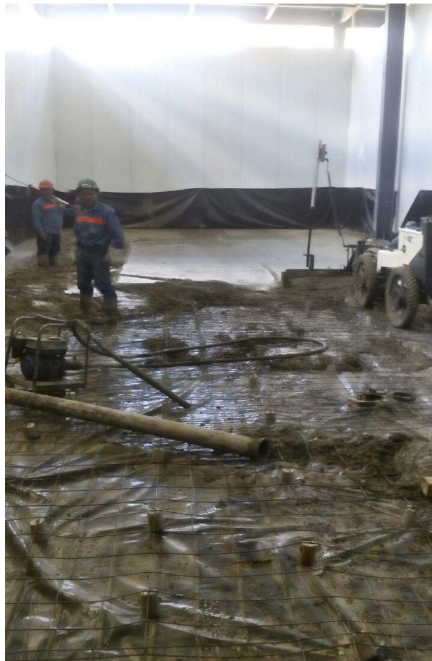
Figura 14. Fundición de concretode piso de cuarto frío
