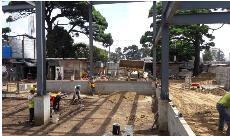
Figura 12. Conformación base desuelo en cuarto frío
