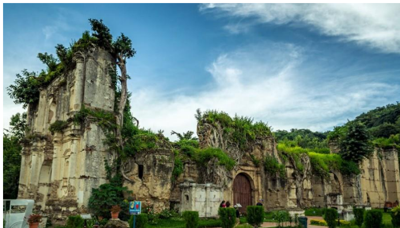
Figura 4. Fotografía de las ruinas de la iglesia de la Concepción
