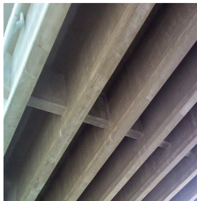
Figura 13. Vigas diafragmas de concreto armado
