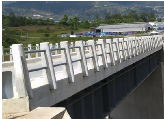
Figura 10. Baranda de concreto armado, con largueros metálicos
