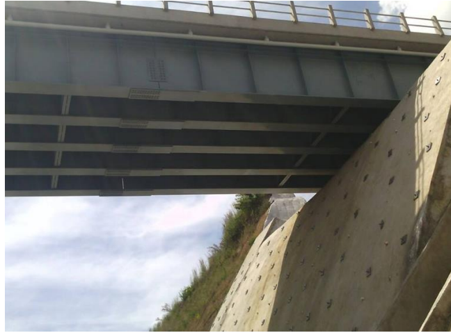
Figura 3. Puente de acero
