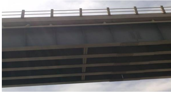
Figura 12. Vigas principales de acero
