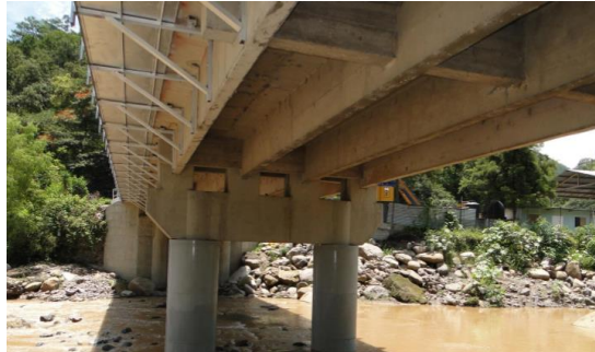
Figura 6. Puente de concreto armado
