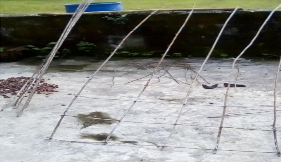
Figura 13. Varillas de acero colectadas para la construcción de rótulos.
