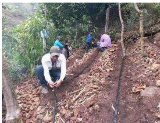
Figura 47 Instalación de sistema de riego por goteo para cultivos de granos básicos en caserío Patuy, Cubulco, B.V.
