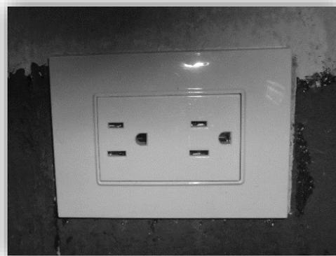
Foto antes y después del cambio de toma corriente; necesario para conectar aparatos y unidad dental ya que tienen tres salidas.
