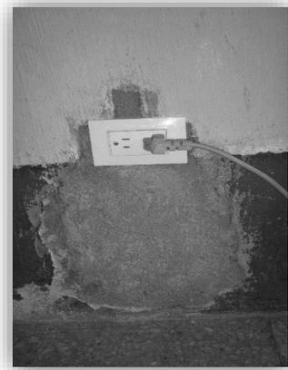
Foto inicial y final de inconvenientes que se presentó en la clínica dental del centro de salud de Patzún, Chimaltenango; colocación de caja, repello en la paredes y de toma corriente de 3 entradas.
