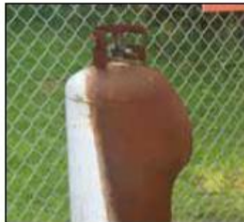
Daño por fuego
