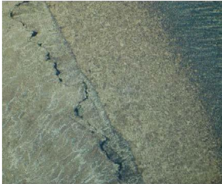
Figura 44. Microestructura de la junta, soldadura húmeda SMAW hecha con acero S420G2 + M: fisura extensa visible en el límite entre la soldadura y la ZAT
