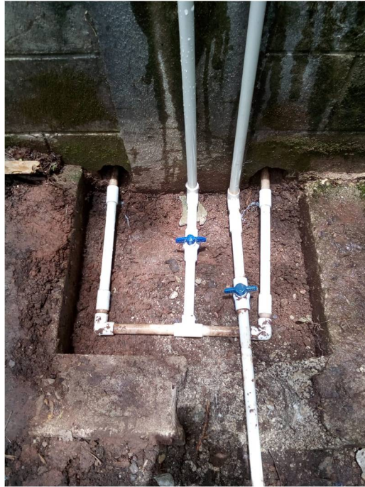
Reparación de tubería y conducción de agua para los sanitarios y mingitorios, colocando llaves de paso y nueva tubería.
