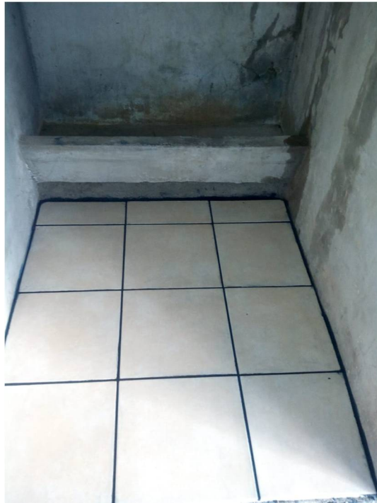
Colocación de piso en área de mingitorio y grifo.
