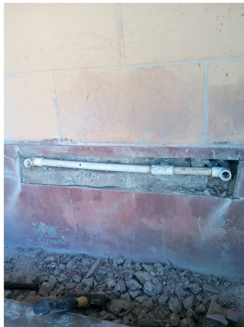
Reparación de fuga de agua de los lavamanos.
