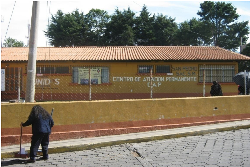
Fachada del Centro de atención permanente, San Pedro Sacatepéquez, San Marcos
