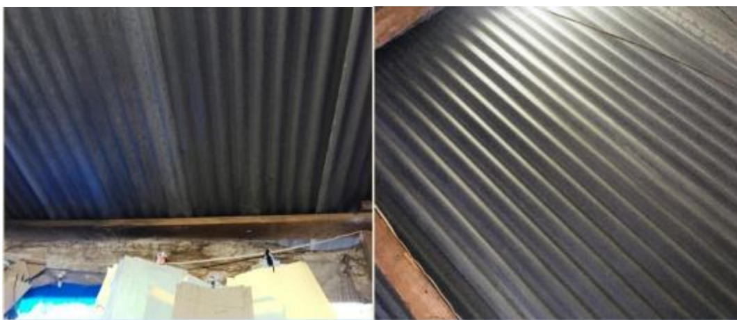
Figura 15. Estado actual de techos
