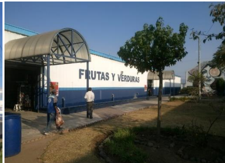
El mercado cuenta con 6 accesos peatonales desde el parqueo.
