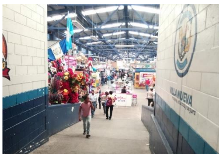
Uso de rampas peatonales en todos los ingresos al mercado
