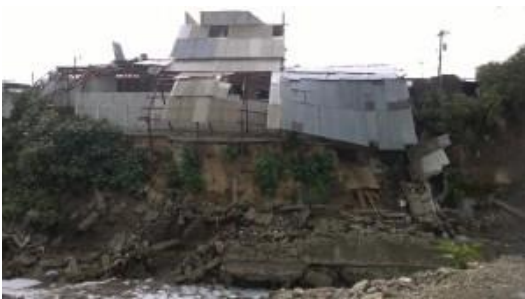
Figura 3.3 Daño de vivienda por Río Pínula «Lahora» Lahora.gt Abril 2018
