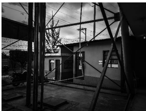
Figura 4.25 Exterior de actuales oficinas administrativas de la Policía Municipal y Policía Municipal de Transito. Fotografía de Denis Dieguez (San Miguel Petapa, Guatemala, 2018)
