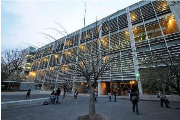
El uso de doble piel para evitar la infiltración directa de rayos solares se observa en fachadas Este y Oeste.
